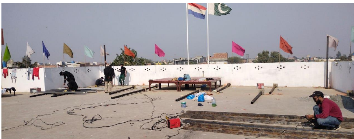
Plaatsing zonnepanelen dak gebouw The Saviours Welfare.
